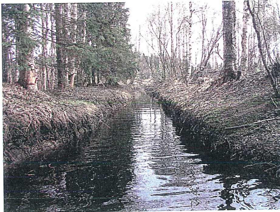
Kuva 3. Eräs Haapajokeen laskevista vesiensuojelullisesti arveluttavista uudisojista. Yhdysojasta puuttuu laskeutusosa ja sivuojista ojakatkokset.
